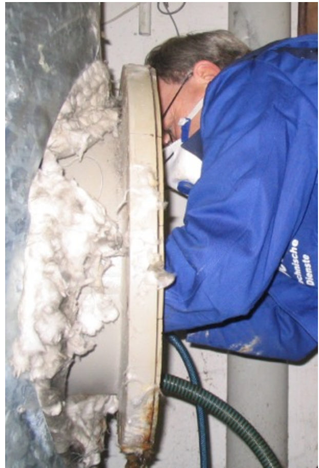
Spezialisten bei der Sanierung eines Warmwasserbereiters in einem Schwimmbad, Foto: DEUS
